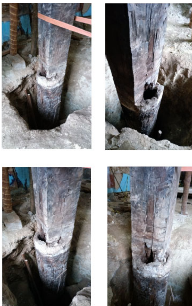
Figura 05: Vistas da estrutura que sofrerá a intervenção. Fonte: Próprio Autor
