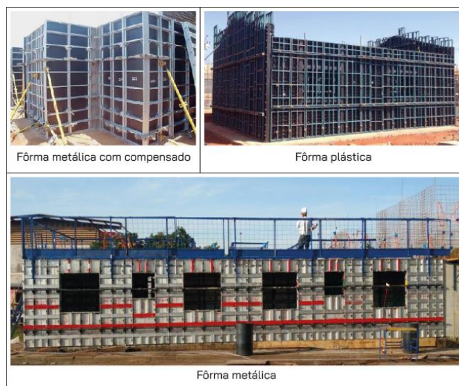
Figura 2. Materiais das fôrmas (elaborado pela Autora, com imagens de [10])
