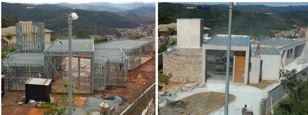
Figura 2 - Residência em LSF: esqueleto estrutural e aspecto final da construção
