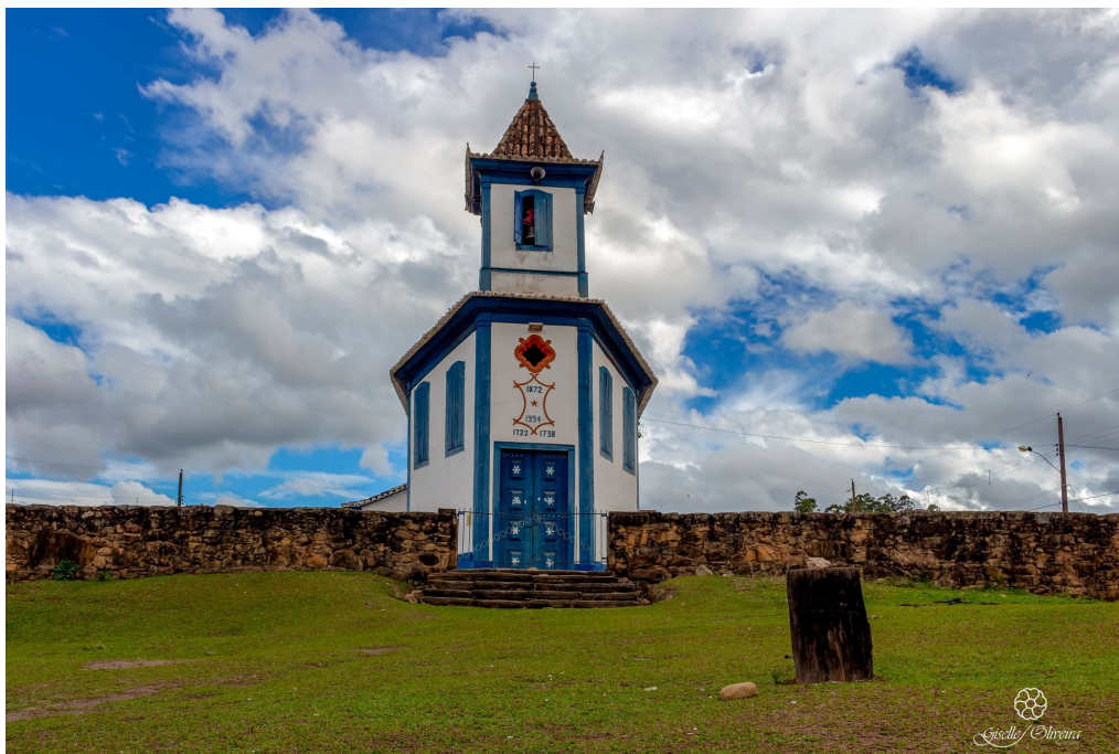
Figura 01: Fachada frontal da Igreja de Nossa Senhora Aparecida Fonte: Internet – conhecaminas.com
