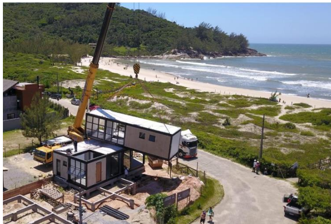
Figura 4: Montagem de edificação modular [4]
