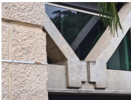
Figura 8: Torre Rio Sul. Vista ampliada do conjunto formado pela treliça e os pilones. Fonte: Acervo da autora.
