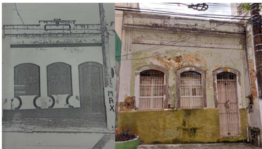
Figura 3: Casa nº 55, IAB e levantamento de campo. Fonte: IAB, 1982 e dos autores, 2023.
