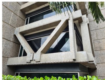
Figura 6: Torre Rio Sul. À esquerda: esquadrias de alumínio e painéis de vidro recuados da fachada. Fonte: Acervo da autora. À direita: Detalhe da estrutura de fixação das esquadrias e painéis de vidro. Fonte: Acervo Rio Sul Shopping Center.
