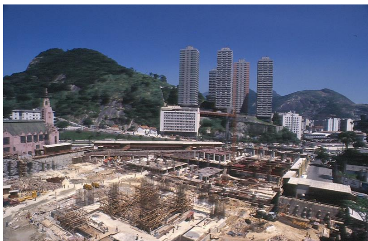
Figura 1: Torre Rio Sul. Canteiro de obras, no início da construção. Ao fundo, as torres do Condomínio Morada do Sol. Fonte: Acervo Rio Sul Shopping Center.
