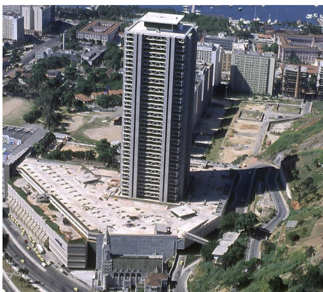
Figura 9: Torre Rio Sul. Fase final da construção. Fonte: Acervo Rio Sul Shopping Center.
