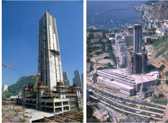
Figura 5: Torre Rio Sul. Fases da construção. Fonte: Acervo Rio Sul Shopping Center.
