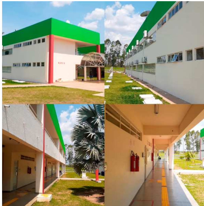
Figura 1(a) Perspectiva do Bloco B, Figura 1(b) Fachada Nordeste, Figura 1(c) Fachada Sudoeste, Figura 1(d) Corredor dos Laboratórios.
