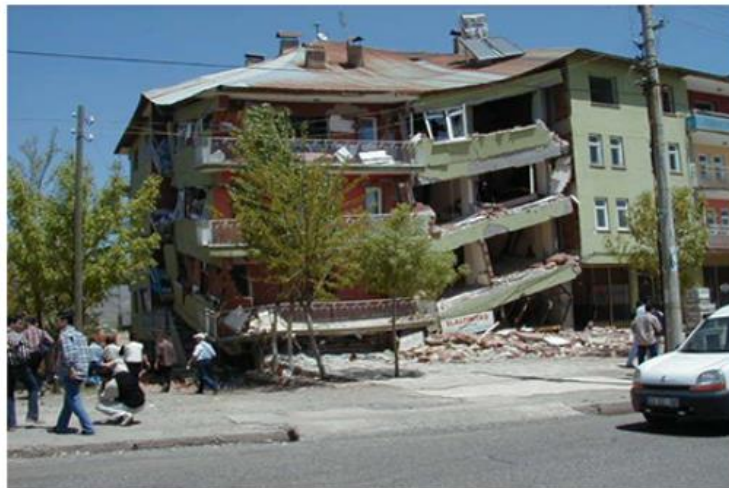
Figura 12 - Colapso de edifícios adjacentes durante o terremoto de Bingö. [19]
