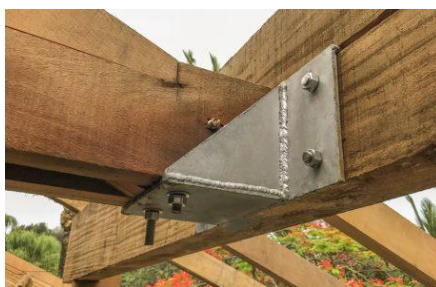
Figura 5 – Reforço de estrutura de madeira com placa de aço [Fonte: 5fachada]
