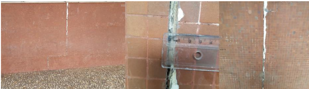
Figura 6: Rachadura vertical (2023).
