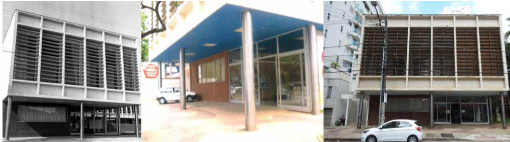
Figura 3: Fachada II. Da esquerda para a direita: 2008 [3]; 2021; 2023.
