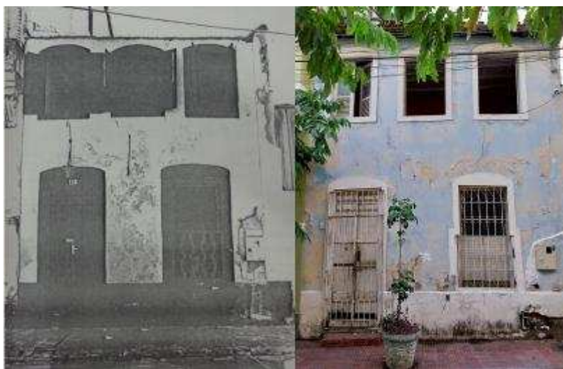
Figura 2: Sobrado nº 29, IAB e levantamento de campo. Fonte: IAB, 1982 e dos autores, 2023.
