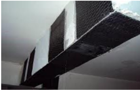
Figura 7 – Mantas de fibra de carbono de viga [12]
