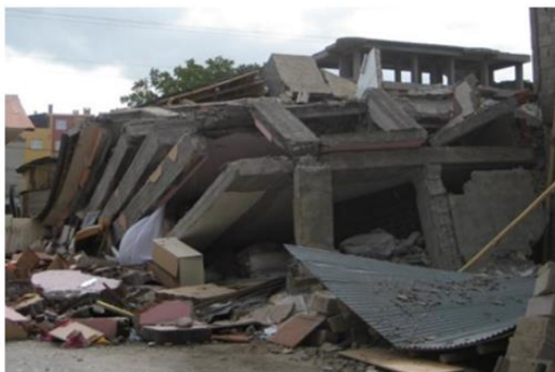
Figura 13: Falha de um edifício devido ao forte efeito viga-coluna fraca durante o terremoto de Van. [19]
