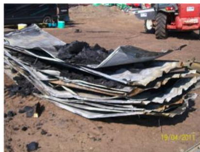
Figura 5: Painel sanduíche com núcleo de poliisocianurato (PIR) pós-incêndio [26]
