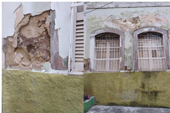
Figura 5: Fachada da casa número 55 na atualidade. Fonte: dos autores, 2023.
